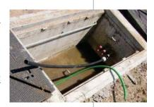
En outre, certaines chambres devront être suffisamment grandes (de type L3T) pour y placer un équipement de dérivations de câbles optiques. Si l'implantation n'est possible que sous chaussée, on utilisera une chambre de type K2C.
