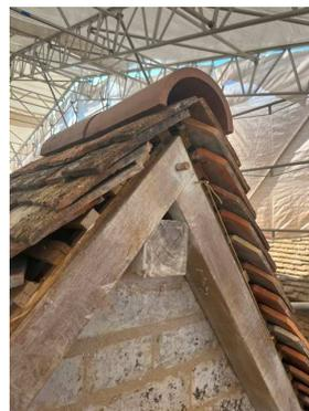
**Le sommet de la charpente est neuf au niveau du bois et la tuile qui est au-dessus est neuve**
